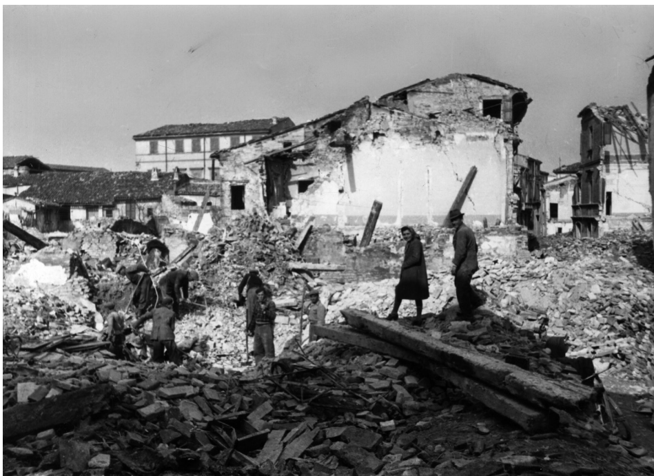
Il centro storico di Rimini in rovina dopo 10 mesi di intensi bombardamenti, dal novembre del 1943 al settembre 1944 ( Archivio fotografico Biblioteca Gambalunga, Rimini ).
