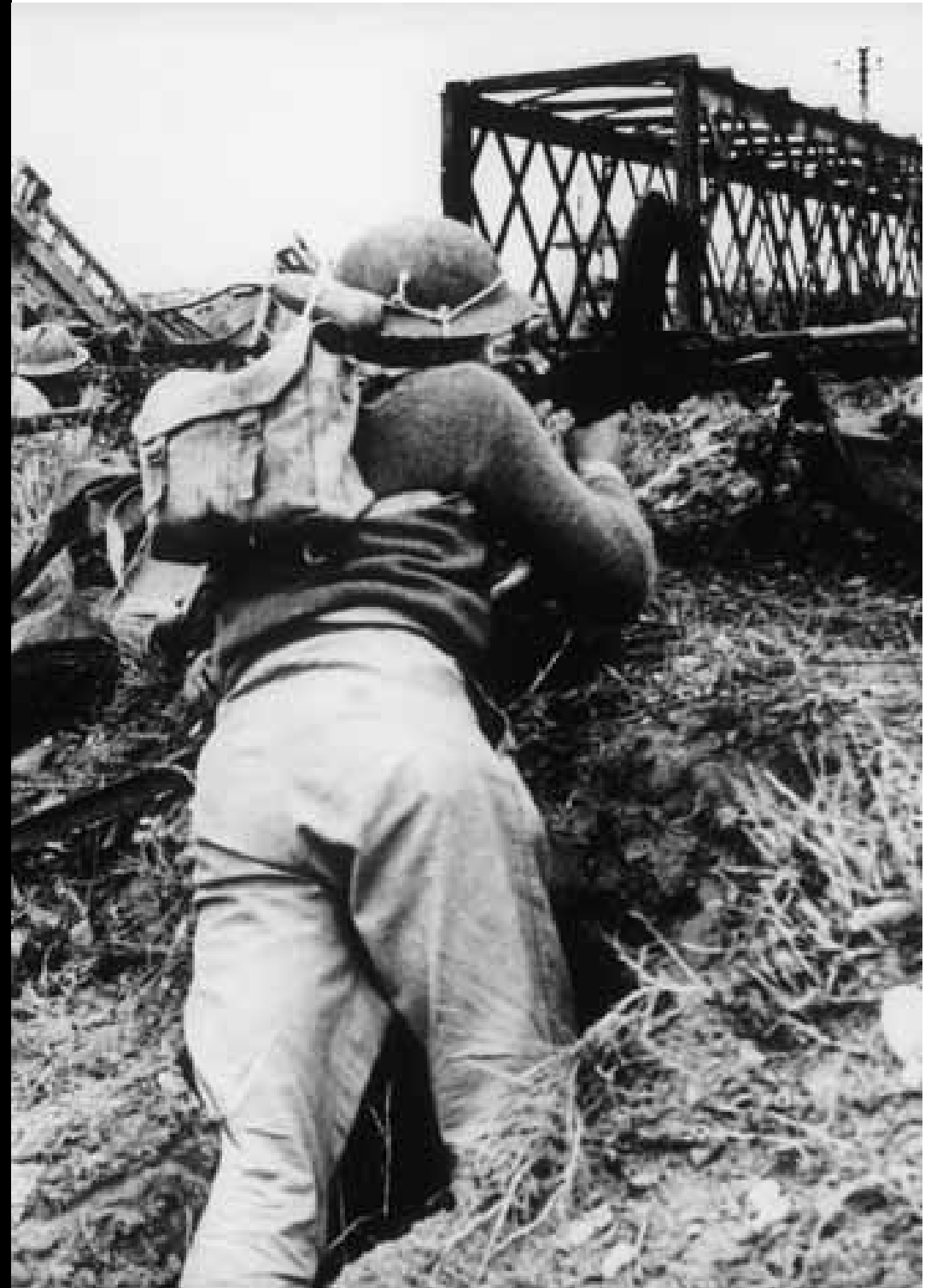
TRUPPE NEOZELANDESI FRA LE MACERIE DEL PONTE DELLA FERROVIA SULL'USO
